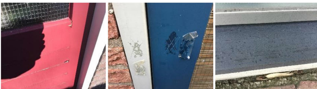
Foto 1: Afbladdering en sterke verpoederen. Deur met zwaardere kleur sterk verkleurd
